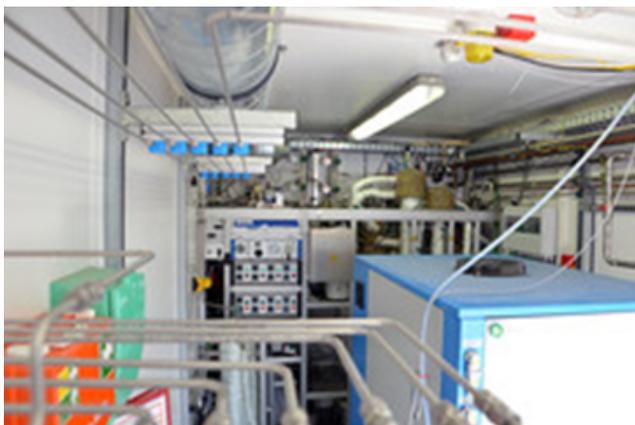
**Figura 28. Sulla destra in blu l'elettrolizzatore, nel fondo l'unità di metanazione [146].**
