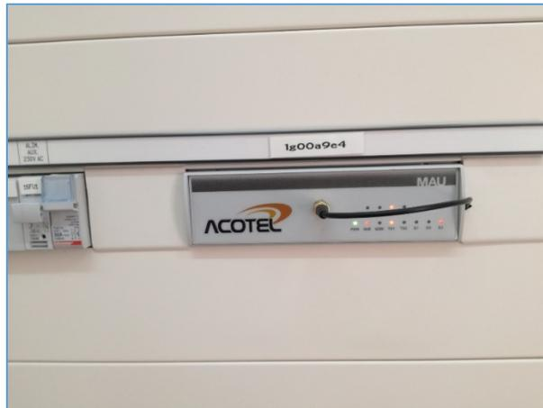
**Figura 3.4. Unità di connessione alla piattaforma Acotel.net MAU.**
