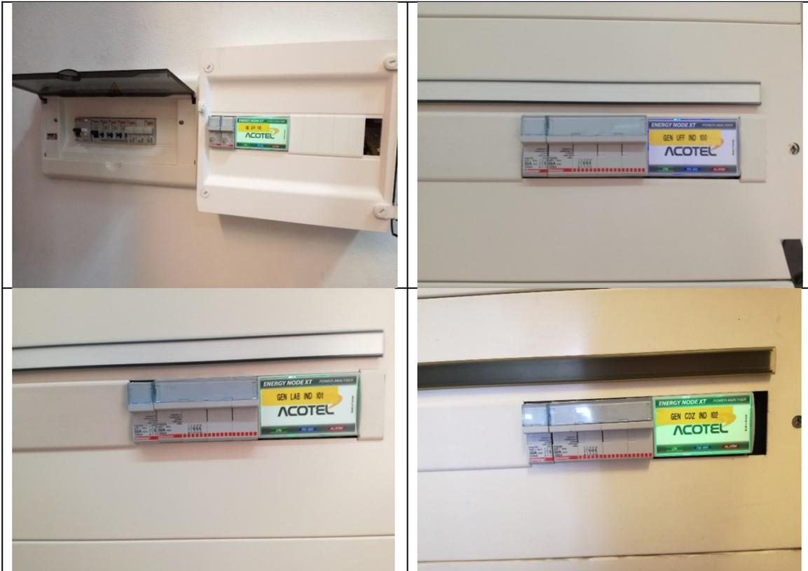
**Figura 3.3. Energy node installati in diverse sezioni dell'impianto elettrico del Centro Ricerche Sotacarbo (ufficio tipo, sez. uffici, sez. laboratori, impianto di climatizzazione).**
