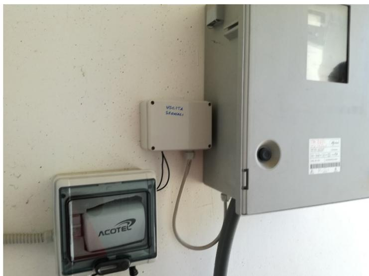
**Figura 3.2. "Mem business" installato nel contatore principale del Centro Ricerche Sotacarbo.**
