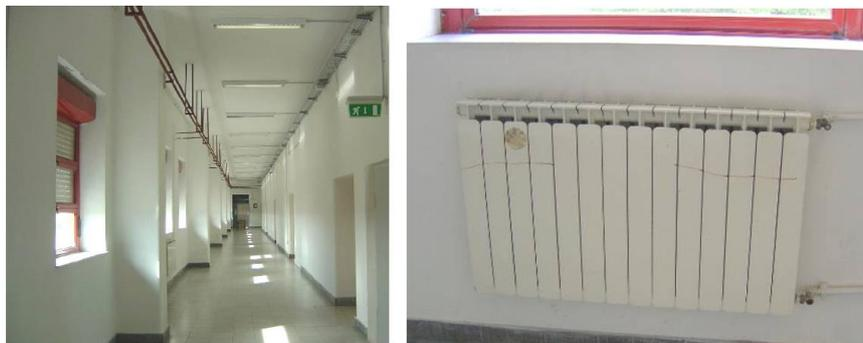
**Figura 4.9. Linea di distribuzione del fluido termovettore e terminale di erogazione.**
