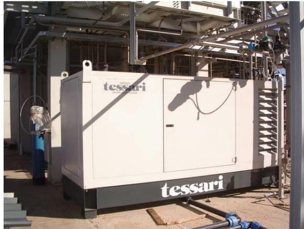
**Figura 8. Gruppo elettrogeno Tessari da 24 kW elettrici.**
