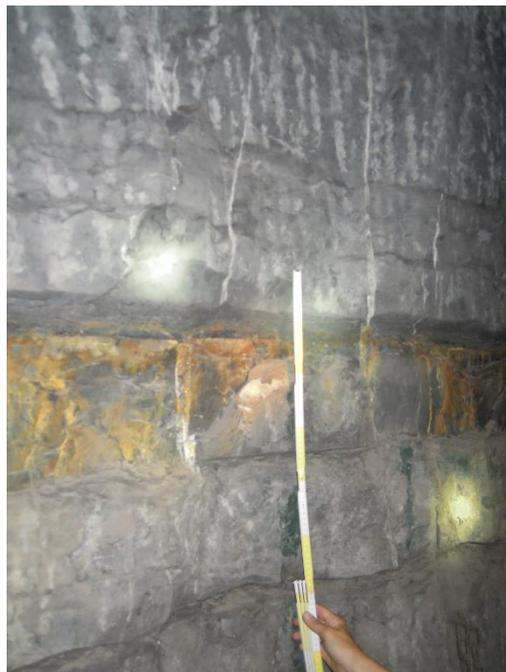
**Figura 1 – a) cavità carsica aperta sul soffitto della galleria lungo il piano di faglia. La maglia della rete è di 7 cm. B) cavità carsiche che si sviluppano lungo la stratificazione. C) cavità carsica con diametro di circa 60 cm sempre lungo una faglia.**
