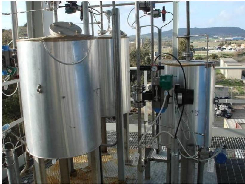
Figura 2.5. Sistema di desolforazione a caldo del syngas.
