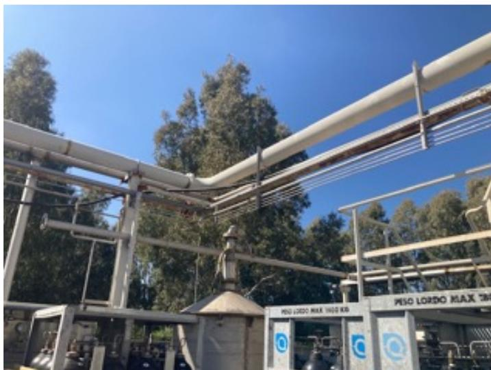
**Figura 4.7. Passaggio in quota delle linee di adduzione gas.**
