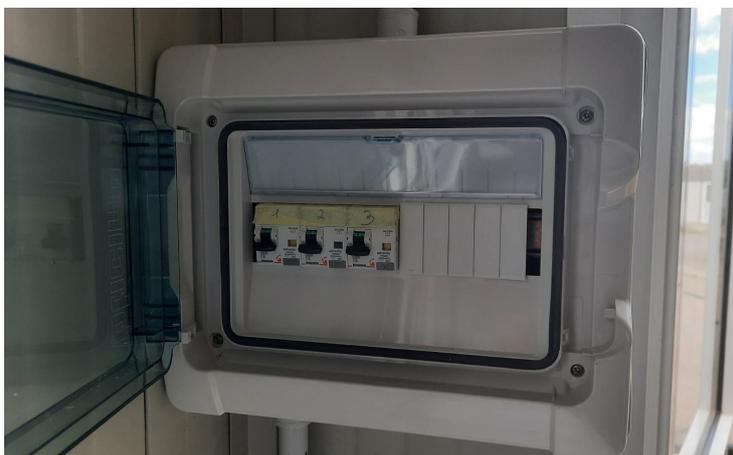
**Figura 4.19. Quadro elettrico del sistema di vaporizzazione CO<sub>2</sub>.**
