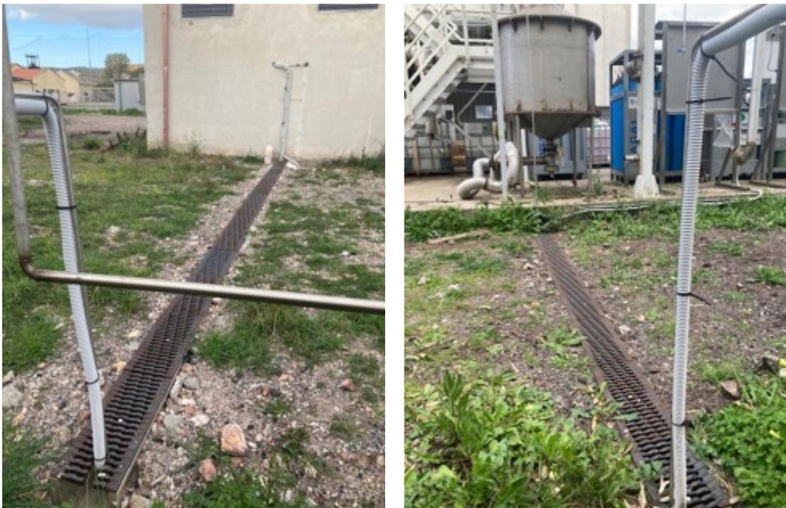
Figura 4.6. Passaggi interrati della linea H<sub>2</sub>, lato box di stoccaggio (a sinistra) e lato utilizzatore (a destra).
