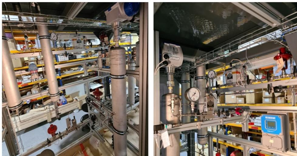
**Figura 3.19. Installazione della sezione di separazione gas-liquido di alta e di bassa pressione.**
