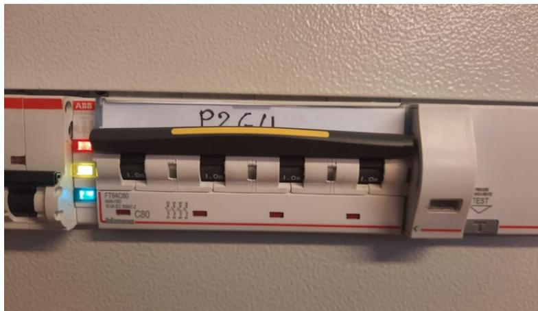
**Figura 4.15. Interruttore generale impianto prototipale.**
