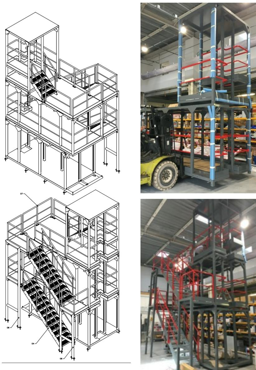
**Figura 3.1. Immagini della struttura dell'impianto durante la fase di realizzazione presso il fornitore.**
