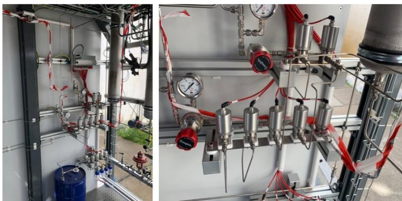
Figura 3.22. Sistema pneumatico di campionamento gas per analizzatore NDIR/TCD (in alto) e per GC (in basso).
