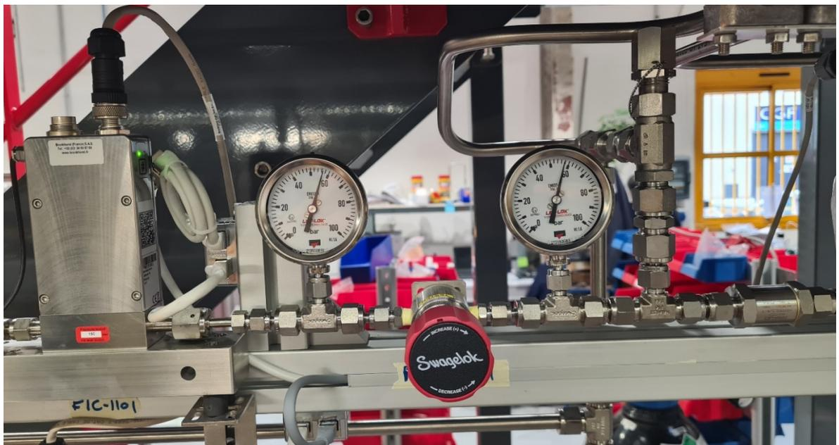
Figura 3.3. Particolare della linea di distribuzione dell'idrogeno e dei suoi componenti.
