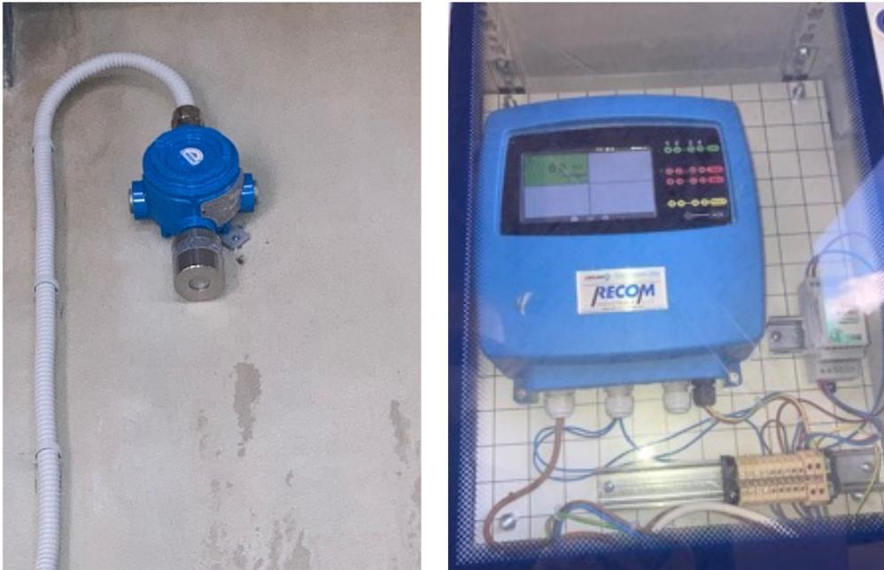
Figura 4.9. Sensore di rilevazione dell' idrogeno (a sinistra) e centralina di gestione (a destra).
