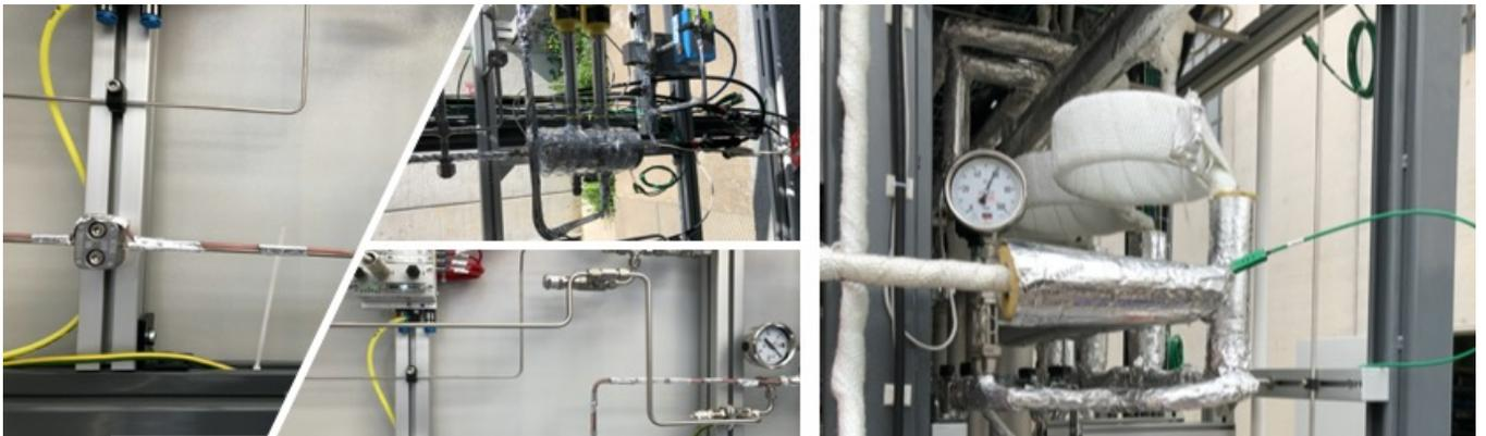
Figura 3.55. Realizzazione coibentazione linee.
