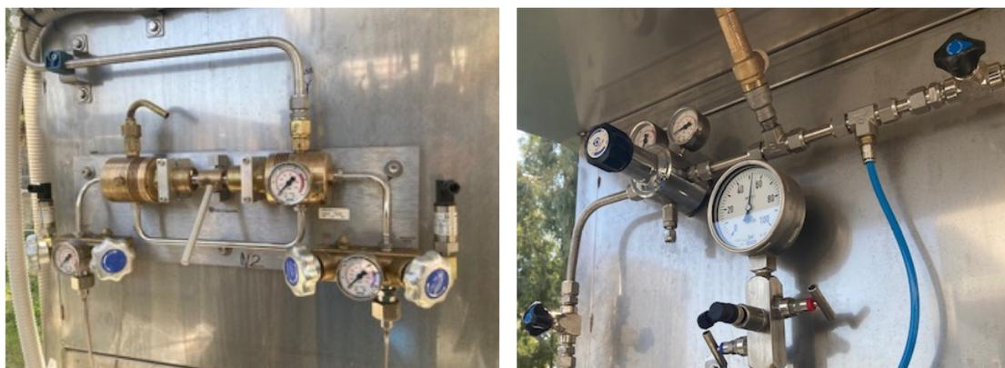
**Figura 4.13. Unità di connessione dei pacchi bombole e derivazione dell'azoto per l'alimentazione della strumentazione pneumatica e per il lavaggio della linea H<sub>2</sub>.**
