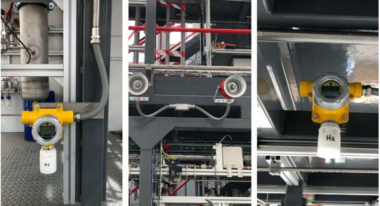
Figura 4.24. Misuratori gas e rilevatori acustici installati nell'impianto.
