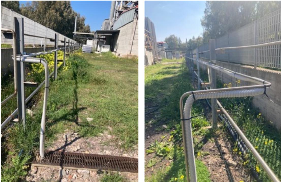
Figura 4.5. Linea di adduzione dell'idrogeno, lato box di stoccaggio (a sinistra) e lato utilizzatore (a destra).
