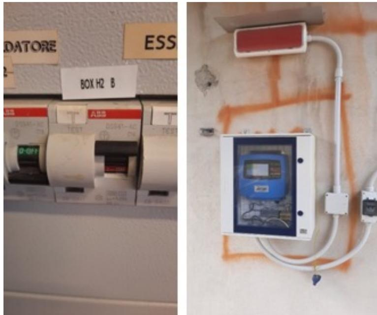
**Figura 4.17. Interruttori sistema di stoccaggio Idrogeno e centralina.**
