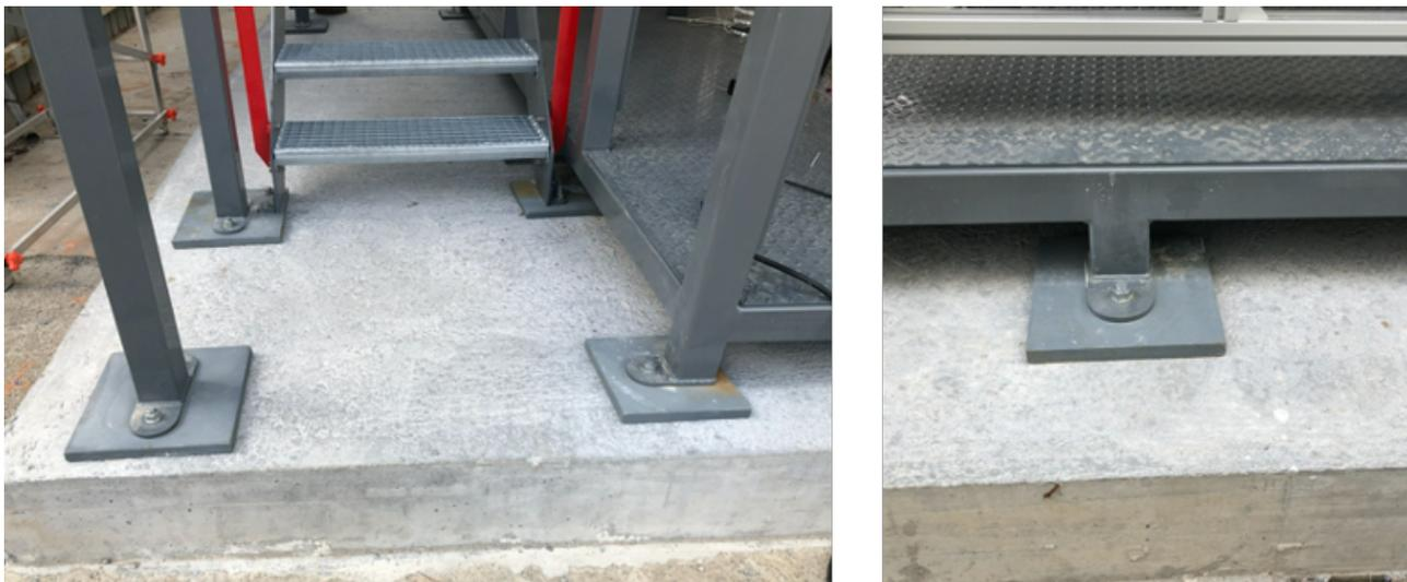
**Figura 3.52. Piastre metalliche per inghisaggio del castelletto dell'impianto al basamento.**
