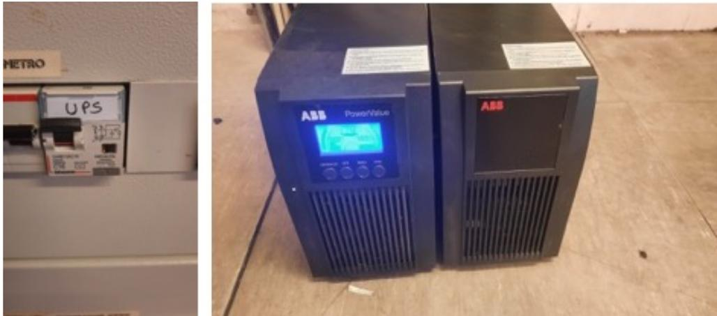
**Figura 4.16. Interruttore generale alimentazione di emergenza e UPS.**
