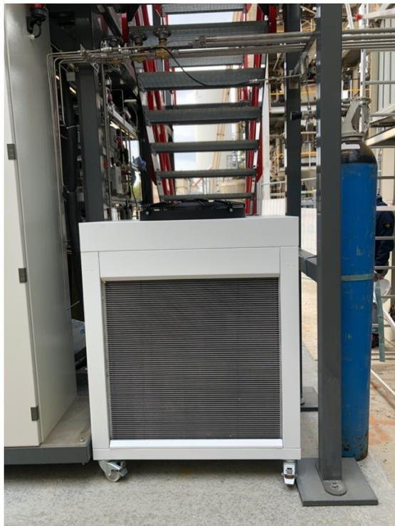
Figura 3.18. Gruppo *chiller* per il raffreddamento e ricircolo dell'acqua.
