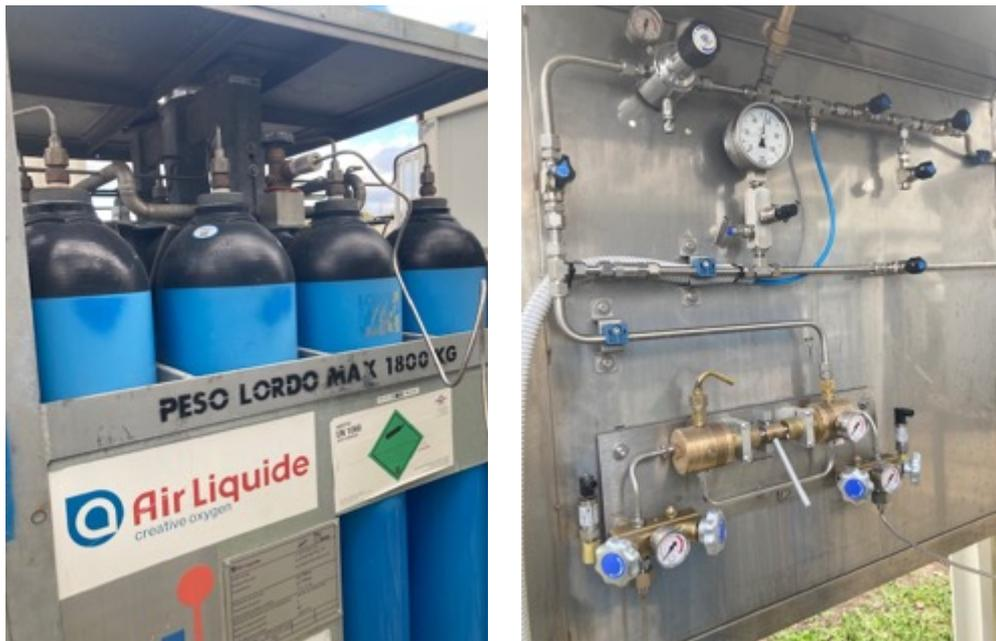
**Figura 4.12. Pacco bombola del sistema di alimentazione dell'azoto (a sinistra) e unità di connessione con sistema di regolazione (a destra).**
