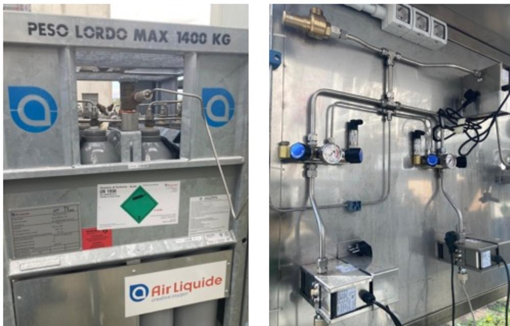
Figura 4.10. Pacco bombola della CO<sub>2</sub> (a sinistra) e unità di connessione con riscaldatori (a destra).
