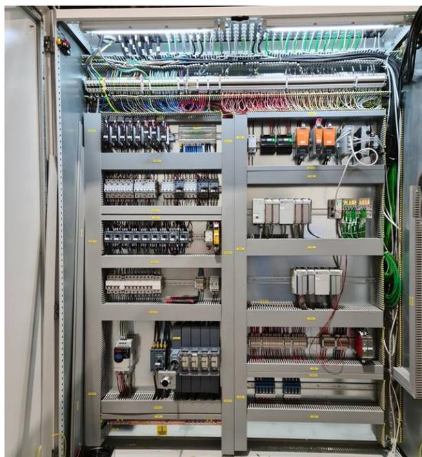
**Figura 3.31. Interno del quadro di regolazione e controllo.**
