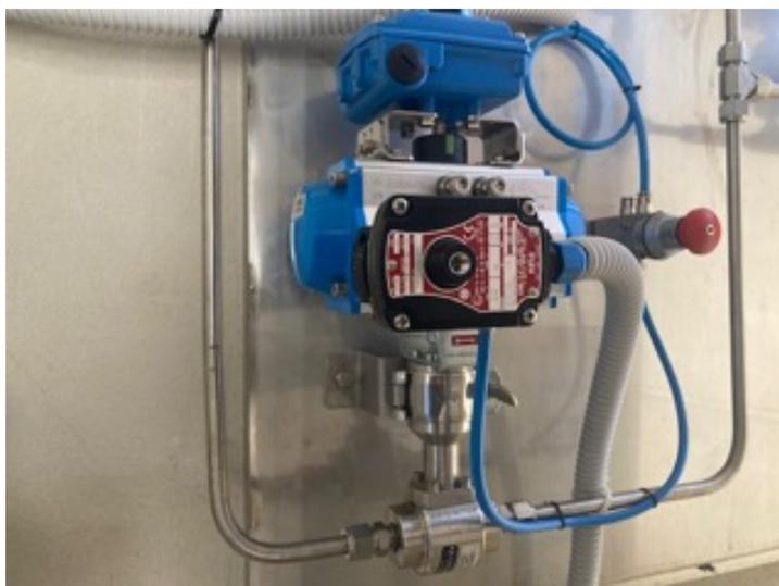
**Figura 4.8. Valvola di arresto di emergenza.**
