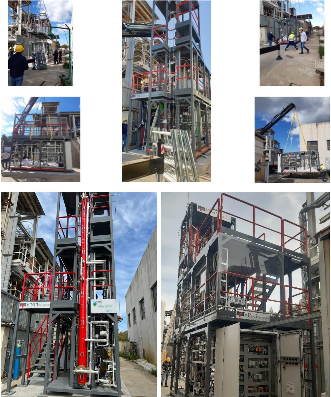
Figura 3.51. Installazione impianto Power-to-Fuels presso la Piattaforma Pilota Sotacarbo.
