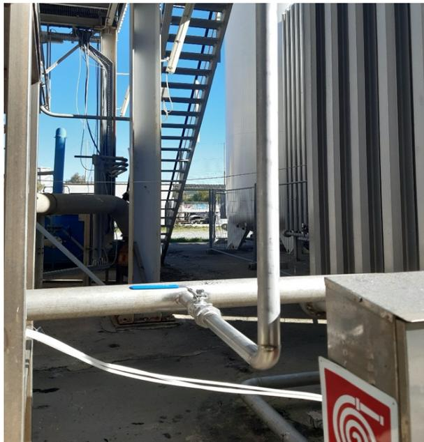
Figura 4.20. Stacco di partenza dell'azoto di inertizzazione.
