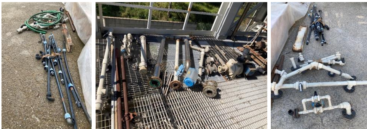
Figura 2.20. Tubazioni, strumenti e apparecchiature dopo la rimozione dalla colonna in polipropilene.
