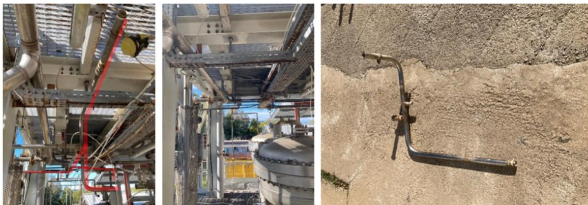
Figura 2.36. Tubazione per la messa in serie dei reattori e area prima e dopo lo smontaggio.
