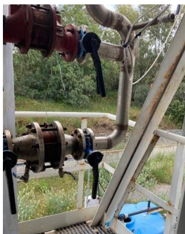
Figura 2.28. Punto di innesto in torcia della tubazione di invio syngas da desolforazione a caldo dopo la rimozione.
