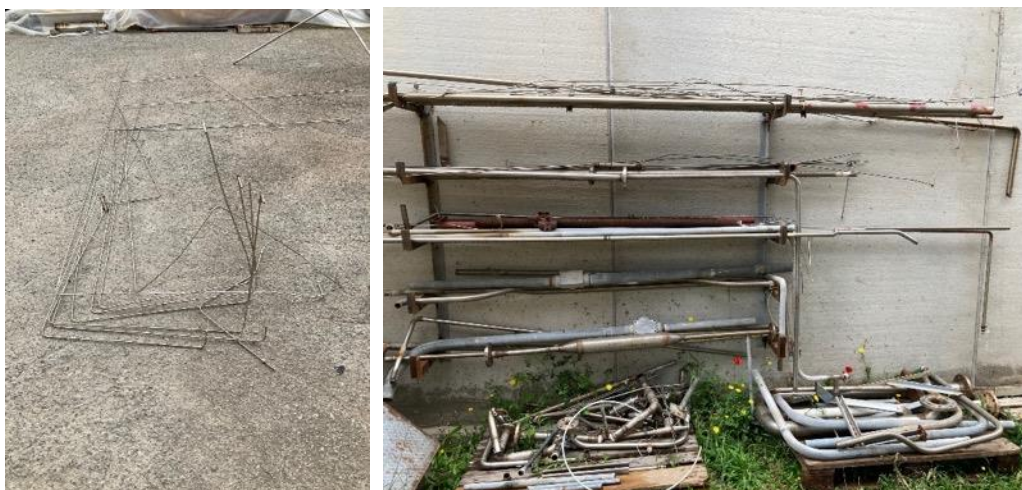
Figura 2.51. Tubazioni in acciaio delle linee di campionamento dopo la rimozione e stoccaggio tubazioni.
