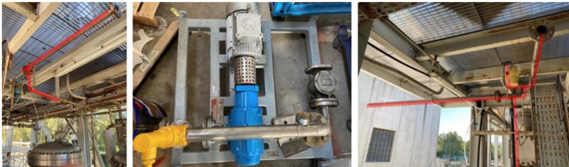
Figura 2.21. Linea syngas al BI002 (sezione iniziale, compressore a lobi CY001, sezione finale con vent e FT104).
