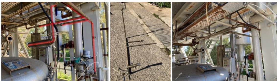
Figura 2.32. Tubazione di collegamento RO001 e RU002 e area, prima e dopo lo smontaggio.
