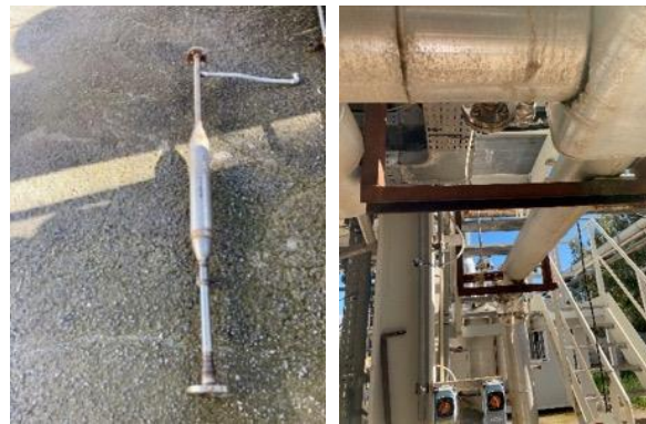
Figura 2.15. Tubazione di innesto CO 2 /O 2 e area dopo lo smontaggio.
