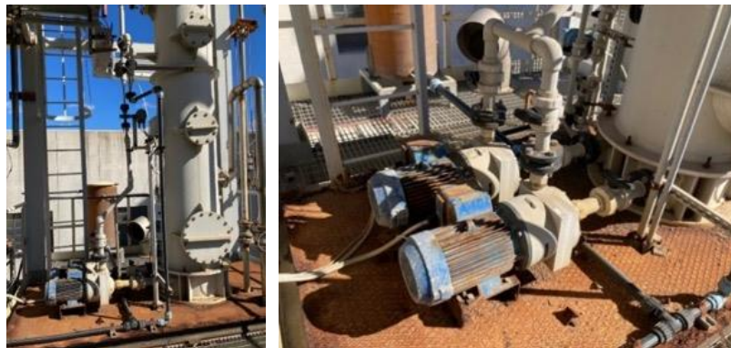
Figura 2.16. Colonna in polipropilene e pompe CX005 e CX006.
