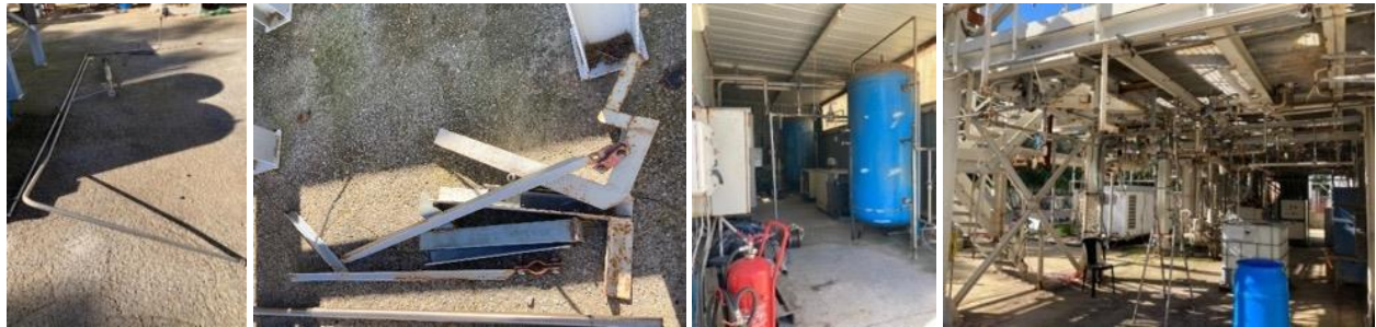
Figura 2.13. Tubazione e supporti smontati e area dopo lo smontaggio.
