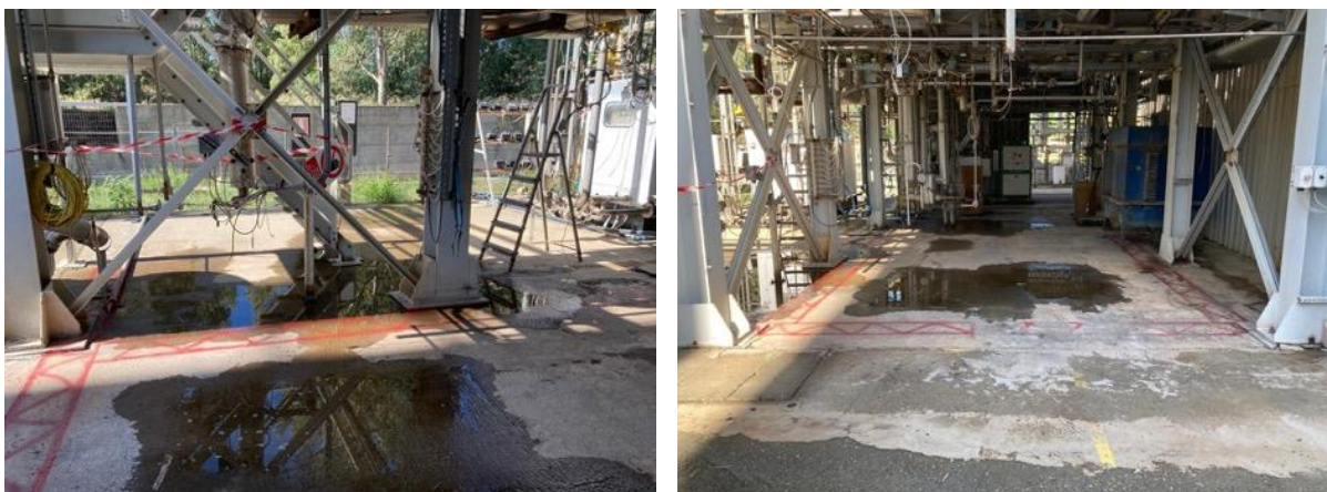
Figura 2.9. Tracciamento cordoli di rinforzo lato ovest e centrali.
