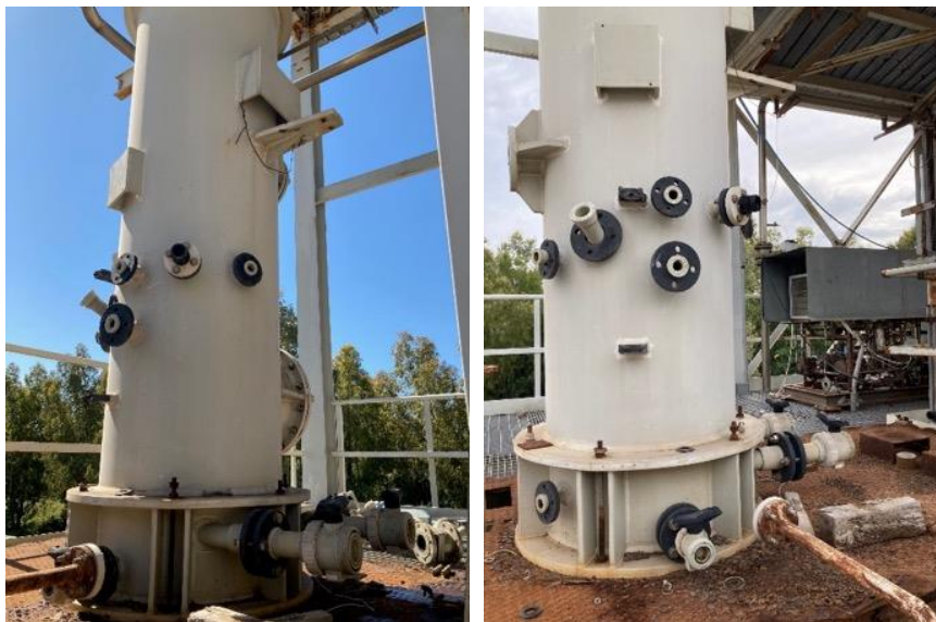
Figura 2.19. Colonna in polipropilene dopo lo smontaggio di tubazioni, strumenti e apparecchiature.
