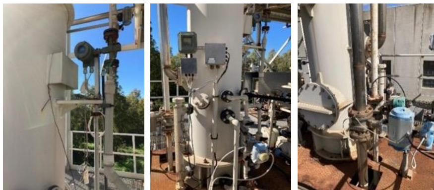
Figura 2.17. FT965, AE975 e AE985, tubazioni inferiori e valvole di innesto N 2 e syngas alla colonna.
