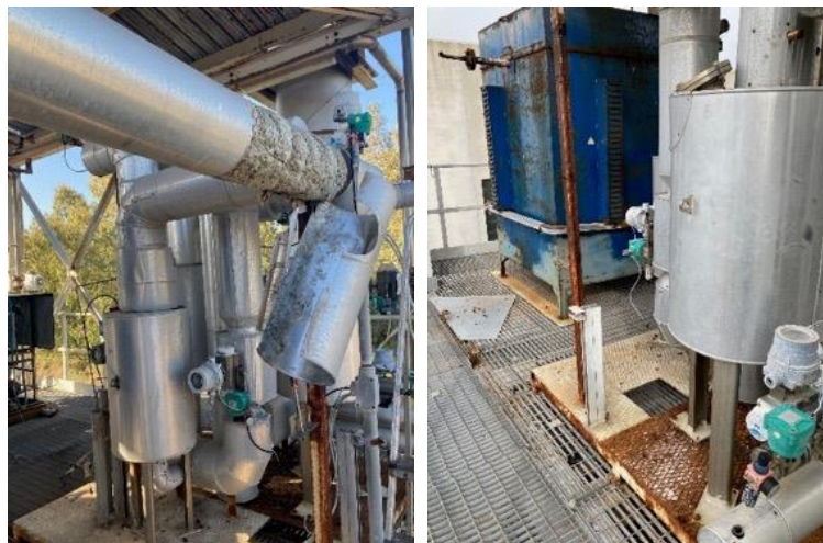
Figura 2.24. Sezione di desolfurazione a caldo prima e dopo lo smontaggio del bypass.
