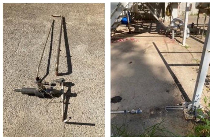
Figura 2.11. Componenti della linea O 2 (a sinistra) e area (a destra) dopo lo smontaggio.
