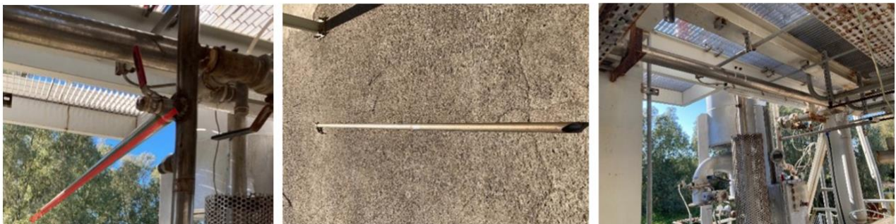
Figura 2.39. Tubazione syngas a vent e area a valle della sezione di cattura CO 2 prima e dopo lo smontaggio.
